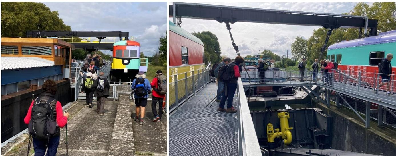
Lors d'une brève vidéo explicative, l'assistance est vivement intéressée par l'exposé de cette prouesse technologique... C'est comme si nous y étions... Le bateau flotte sur un « **coin** » d'eau dans l'étroit et étanche chenal ! La péniche est poussée avec son eau (ou retenue en descente) par un puissant vérin mu par deux locomotives...
