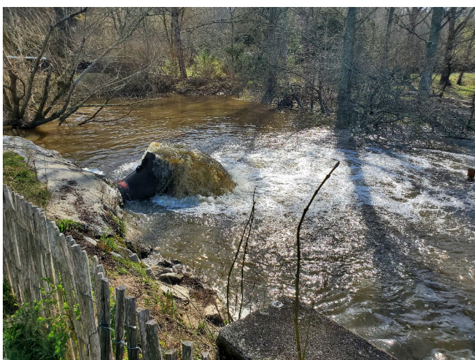
Sortie de la buse de déversement des eaux pompées du marais vers le canal
